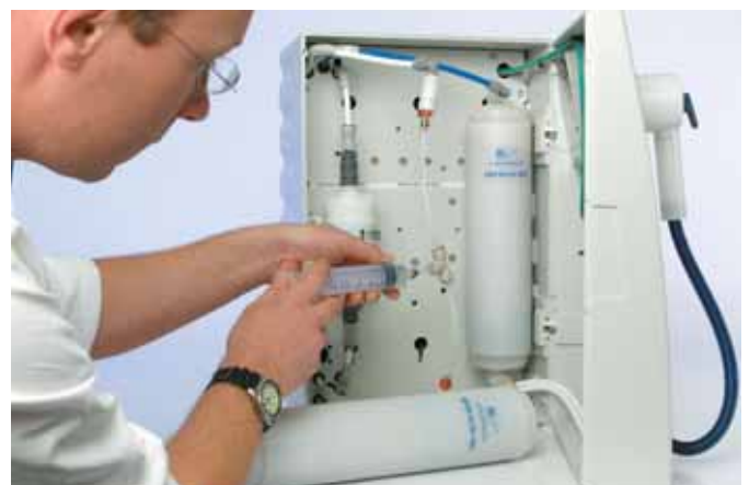
Abb. 7: Desinfektionsvorgang bei einem Wasseraufbereitungssystem
